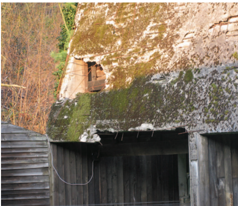
Zu sanierende Beton Schießblenden (50-Meter- und 100-Meter-Stände)
