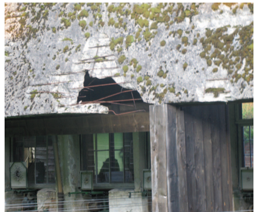
Zu sanierende Beton Schießblenden (50-Meter- und 100-Meter-Stände)
